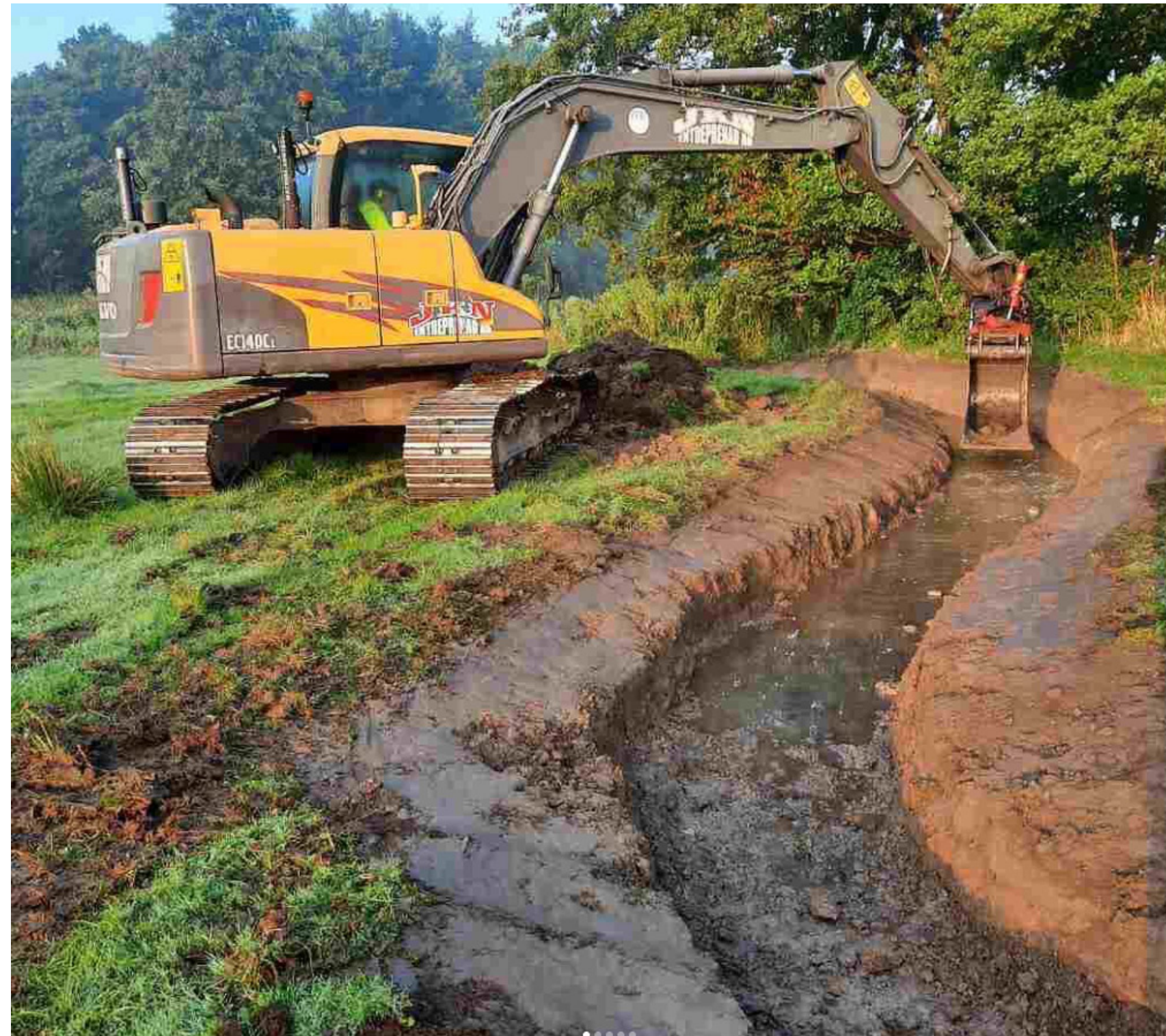
Bild 23. Grävning av ny fåra genomförs avskilt från befintlig fåra. Anslutning till den befintliga åfåran görs vid lågt vattenflöde för att undvika grumling. När en ny sträcka anslutits kan den ursprungliga fåran fyllas igen, delsträcka efter delsträcka, med start nedströms.
